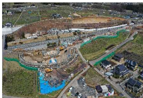
座光寺スマート IC 施工状況 R02.3 月
